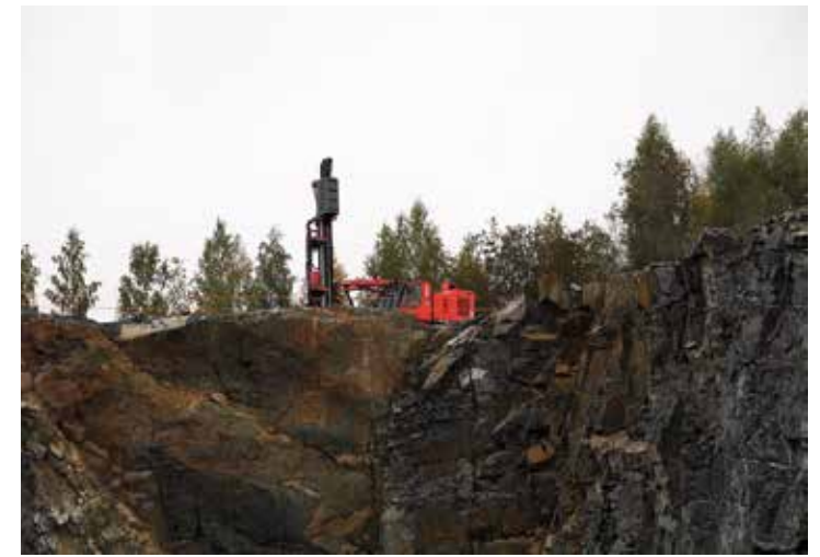
↑ Ennen räjäyttämistä kallioseinämään porataan reiät panostusta varten. Seinämän muoto on etukäteen skannattu porauksen onnistumisen varmistamiseksi.
